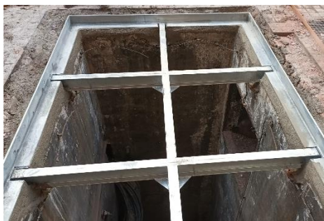
Instal·lació de marc de la trapa de traf
