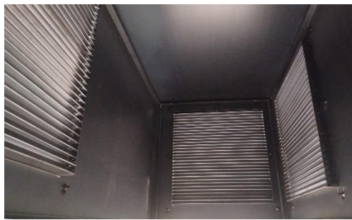
Calaix de ventilació en acer corten (l'acabat d'aspecte corten s'aconsegueix amb l'envelliment del material ja tractat)
