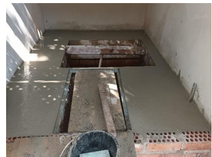
Formigonat a cota final
