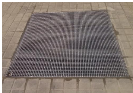
Reixa antilliscant col·locada
