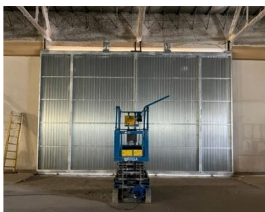
Fabricació i instal·lació porta corredissa de grans dimensions, motoritzada, amb guies i reforços.
