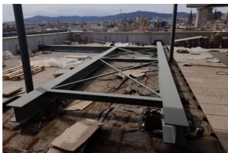
Fabricació i instal·lació d'ancada grans dimensions per a grup generador de l'Aj. Barcelona
