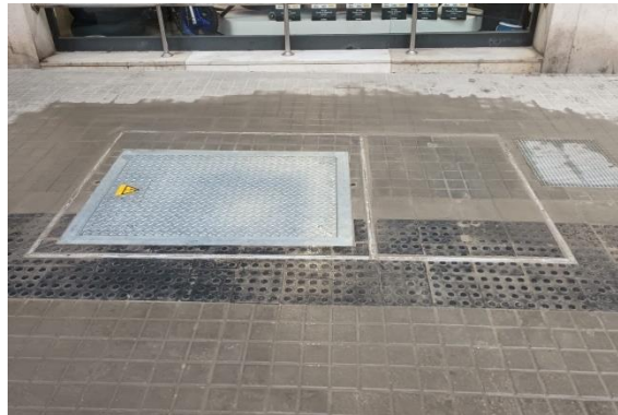
Trapa mixta acabada de pavimentar
