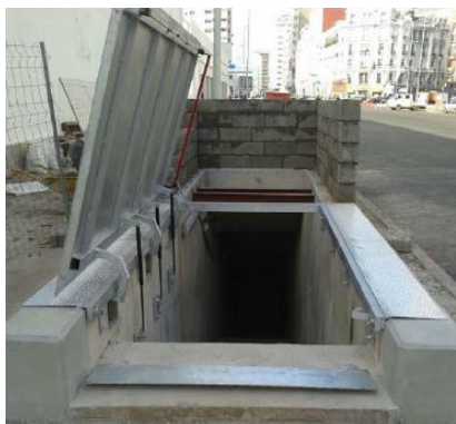
Trapes hidràuliques, per sortida d'emergència de túnels (Casablanca – Marroc)
