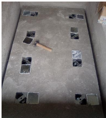
Llosa formigonada (en obra)
