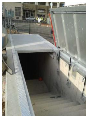
Trapes hidràuliques, per sortida d'emergència de túnels (Casablanca – Marroc)
