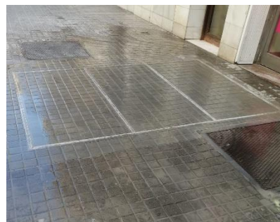
Trapa de tref acabada de pavimentar
