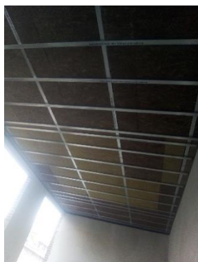
Instalación paneles lana de roca
