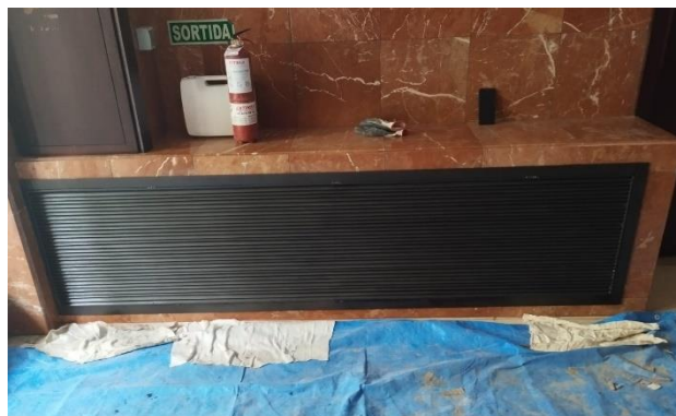
Instalación de eja de ventilación en entrada comunidad vecinos
