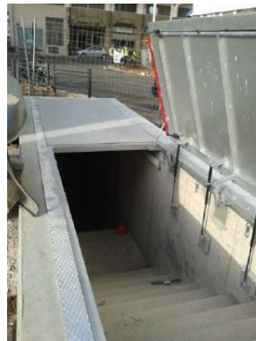
Trapas hidráulicas, para salida de emergencia de túneles (Casablanca – Marruecos)
