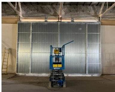
Fabricación e instalación puerta corredera de grandes dimensiones, motorizada, con guías y refuerzos.
