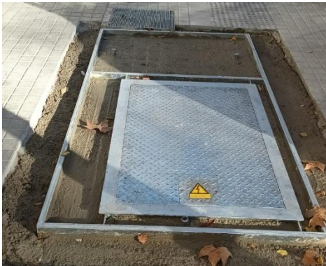
Trapa mixta hormigonada
