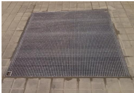
Reja antideslizante colocada
