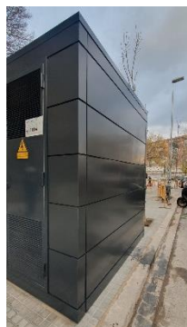
Revestimiento de fachada y cubierta de edificación existente, Mediante subestructura de aluminio y paneles tipo composite de aluminio.
