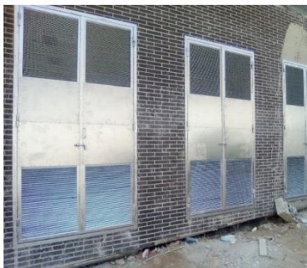
Puertas ventilación superior e inferior, con ángulo invertido
