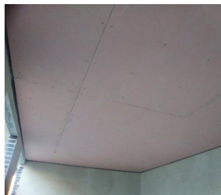
Instalación placas de yeso
