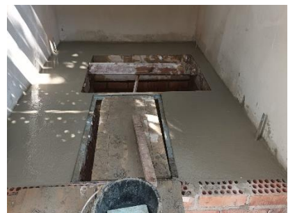
Hormigonado a cota final
