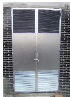
Puerta ventilación superior e inferior, con ángulo normal
