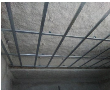
Instalación varillas y perfiles
