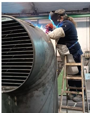
Ventilación tipo barco, fabricación
