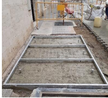
Hormigonado de la trapa de trafo
