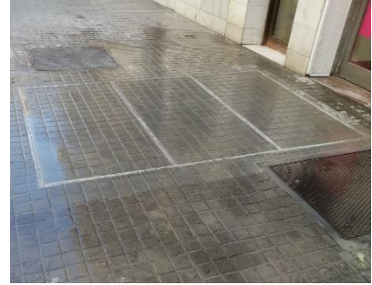
Trapa de trafo recién pavimentada
