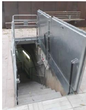
Trapa hidráulica especial en la Calle Putxet (Barcelona)
