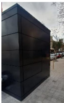
Revestimiento de fachada y cubierta de edificación existente, Mediante subestructura de aluminio y paneles tipo composite de aluminio.
