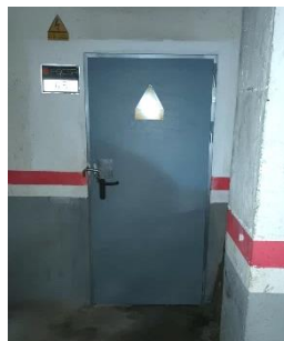
Puerta RF simple instalada
