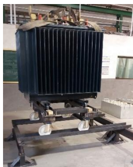
Funcionamiento carro con trafo
