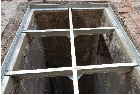
Instalación de marco de la trapa de trafo
