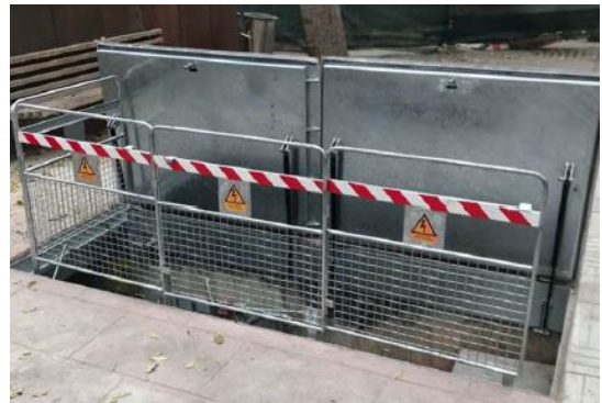
Trapa hidráulica especial en la Calle Putxet (Barcelona)
