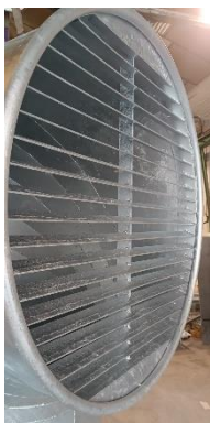
Ventilación tipo barco, detalle
