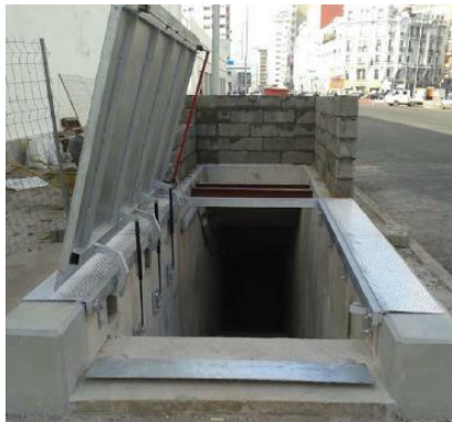
Trapas hidráulicas, para salida de emergencia de túneles (Casablanca – Marruecos)
