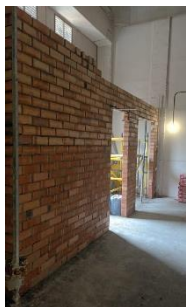
Construcción de vestíbulo de independencia para colocación de puerta RF
