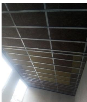
Installation de panneaux en laine de roche
