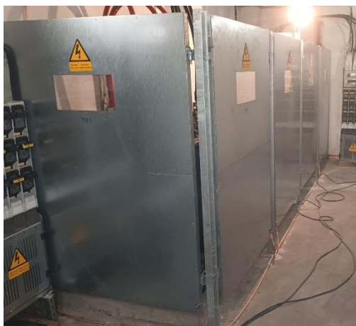
Ensemble de cloisons avec poteaux
