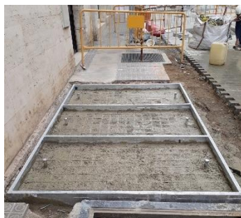
Bétonnage du piège
