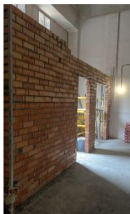
Construction du lobby de l'indépendance pour le placement de la porte RF
