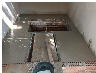
Bétonnage au niveau final
