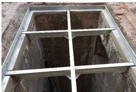
Installation du cadre du piège
