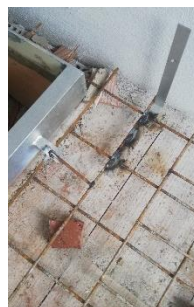
Placement des plaques
