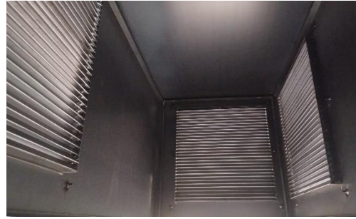
Boîte de ventilation en acier Corten (La finition à l'aspect corten est obtenue avec le vieillissement du matériau déjà traité)
