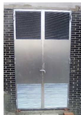
Porte d'aération supérieure et inférieure, avec angle normal
