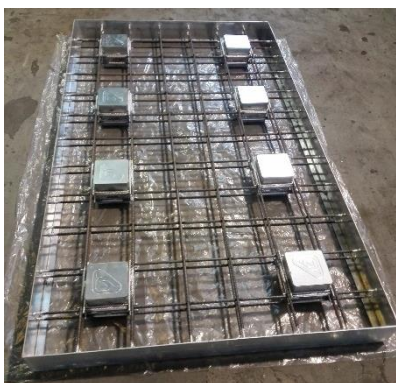
Dalle avec quais (non bétonnée, en atelier)
