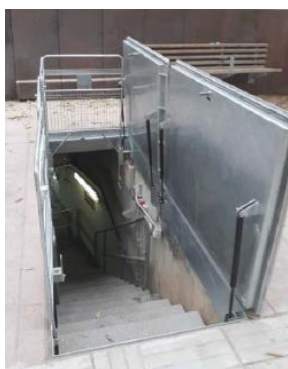
Piège hydraulique spécial dans la rue Putxet (Barcelone)
