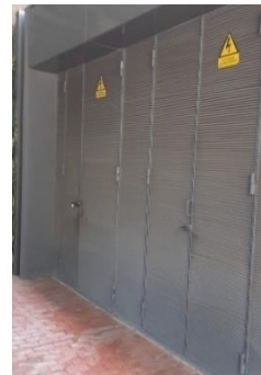
Fixé sur la façade avant, Entre les portes de lamadas
