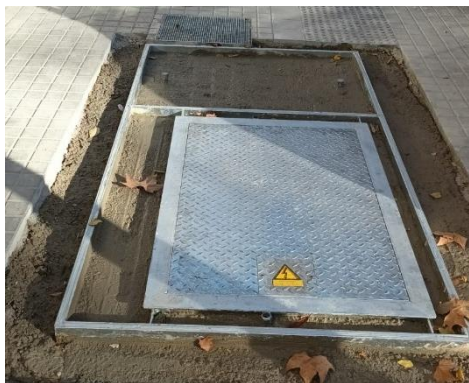
Trapa en béton mixte
