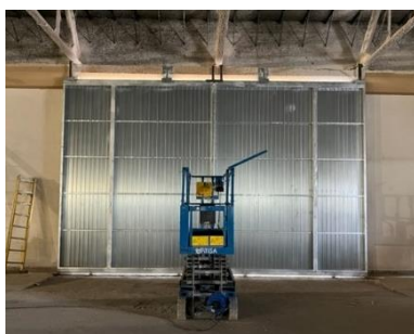
Produzione e installazione di grandi porte scorrevoli, motorizzato, con guide e rinforzi.
