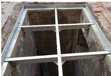
Installazione del telaio della trappola
