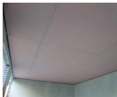
Installazione di cartongesso
