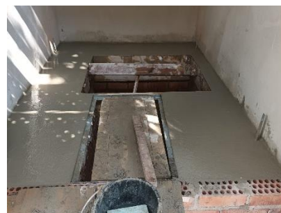
Calcestruzzo a livello finale
