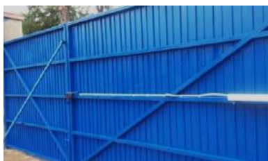
Produzione e installazione di porte motorizzate per sottostazioni
