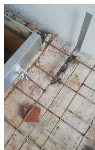
Posizionamento della piastra
