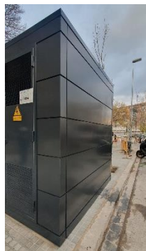
Rivestimento di facciata e tetto di edificio esistente, Attraverso sottostruttura in alluminio e pannelli compositi in alluminio.
