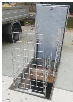
Sifone idraulico in calcestruzzo e pavimentabile
