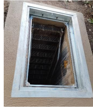
Telaio del sifone a tenuta stagna
