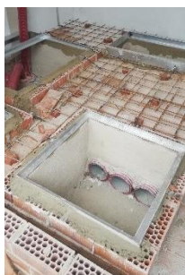
Posizionamento della mesh
