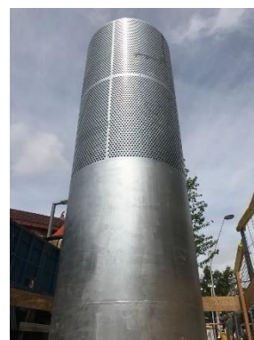
Grande torre di ventilazione, Mercat Sant Antoni, Barcellona
