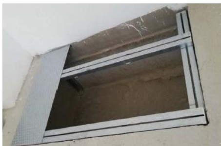
Bancada MT no Centro de Transformação
