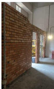
Construção do lobby da independência para colocação de portas RF
