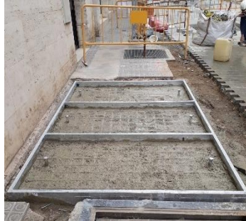
Concretagem da armadilha
