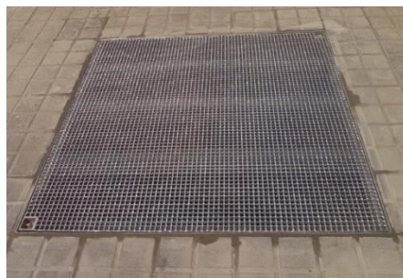
Grelha antiderrapante colocada
