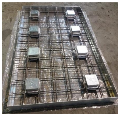
Laje com docas (não concretada, em oficina)
