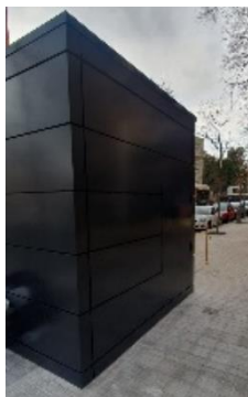
Revestimento de fachada e telhado de edifício existente, Através de subestrutura de alumínio e painéis compostos de alumínio.
