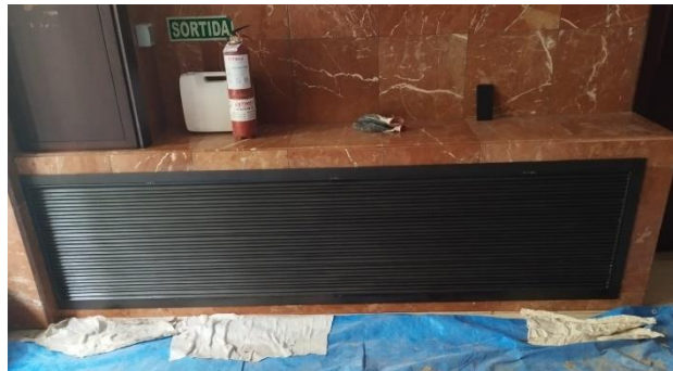
Instalação de ventilação eja Na entrada da comunidade vizinha
