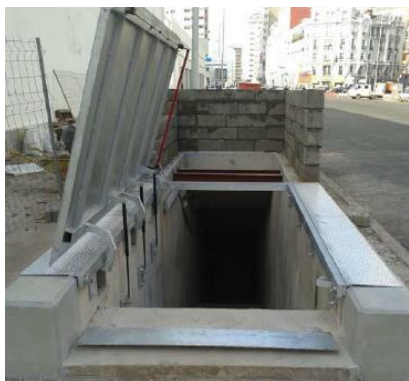
Armazenamento hidráulico para saída de emergência do túnel (Casablanca – Marrocos)
