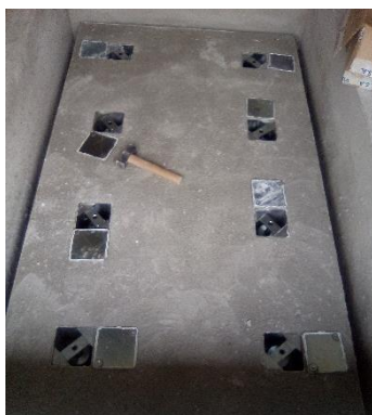
Laje de betão (no local)
