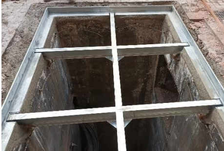
Instalação do quadro do trap
