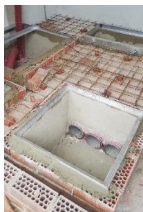
Colocação de malha
