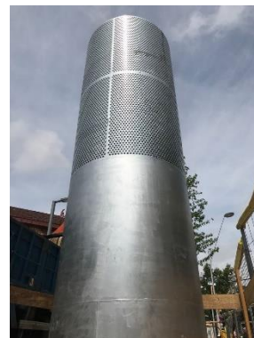
Grande torre de ventilação, Mercat Sant Antoni, Barcelona
