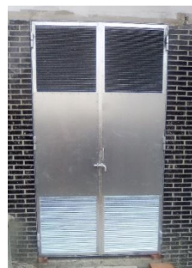
Porta de ventilação superior e inferior, com ângulo normal
